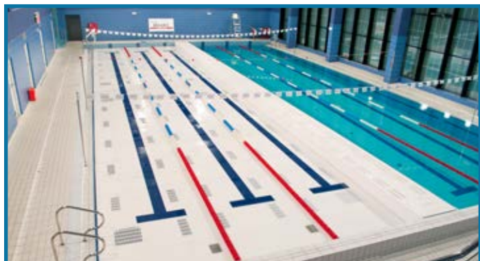
Centre d'éducation sportive, Szczecin (Pologne): Fond mobile & Mur mobile à déplacement vertical
