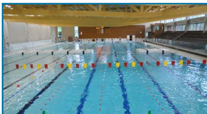
Rozenbroeken, Gand (Belgique): Fond mobile & Mur mobile à déplacement vertical en 3 parties
