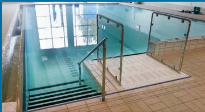
Alvesta Simhal, Alvesta (Suède): Fond mobile, escalier intégré et plateforme mobile Variolift
