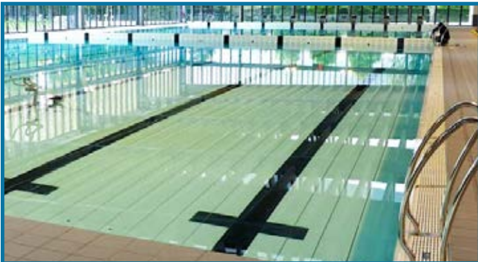
Centre Aquatique Municipal, Annemasse: Fond mobile et Mur basculant sur charnières
