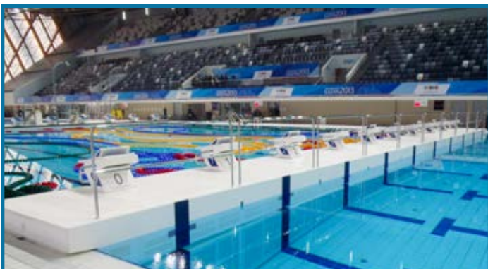
Centre Aquatique National, Kazan (Russie): Fonds mobiles & Mur mobile à déplacement horizontal
